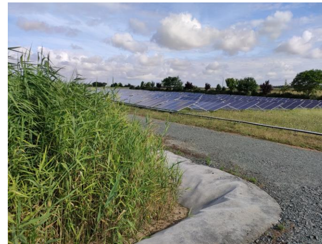
Panneaux solaires mobiles installés à proximité du bassin d'épuration sur lit de roseaux. Site Anett Atlantique, juillet 2023.
